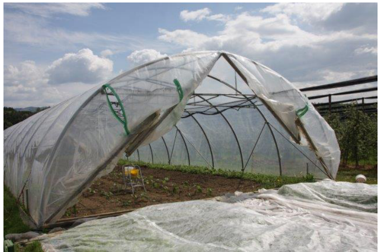
2/ Le pignon en position ouverte. Un trou dans la couverture du battant gauche a été réparé avec du ruban adhésif vert. En effet, nous avions d'abord réalisé un dispositif de fermeture provisoire où le plastique battait au vent s'il était relevé, si bien qu'il a fini par se déchirer là où il avait été plié au moment de la livraison. Mettre en place le pignon dès le début et ne pas se contenter d'une solution provisoire permettrait d'éviter ce problème. Par ailleurs, il faut veiller à bien visser le plastique sur les lisses en bois à de multiples endroits, faute de quoi le vent finira par arracher le film.
