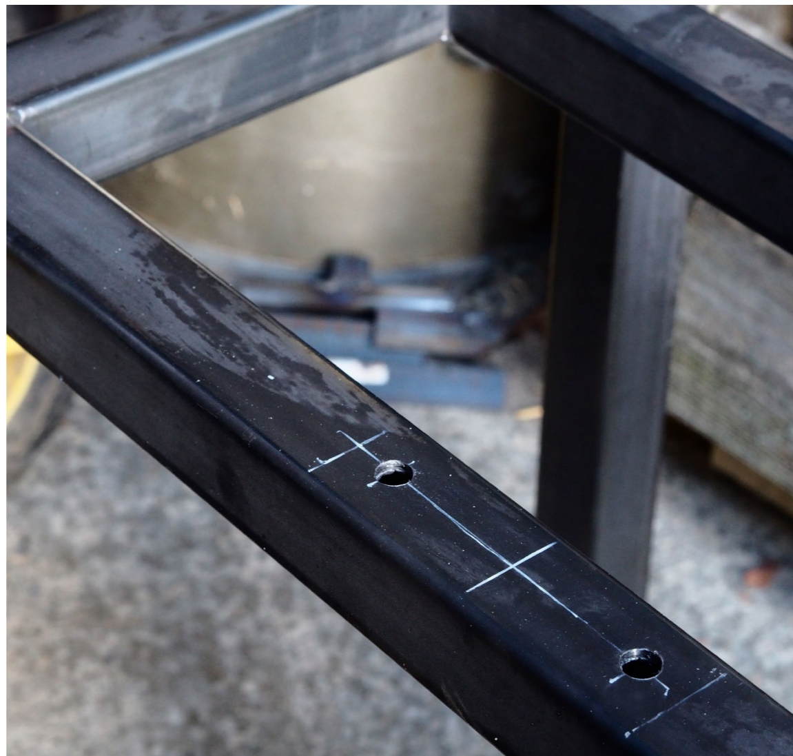
Perçage et positionnement des paliers à roulement
